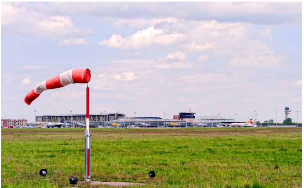
Das Vorhandensein eines beleuchteten Windsacks ist eines der 29 Flughafen-Bewertungskriterien.
