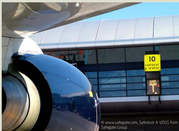
Bild 4: Von Beiden Pilotensitzen aus erkennbares Andockführungssystem (Quelle: [www.safegate.com](http://www.safegate.com), Safedock A-VDGS from Safegate Group)
