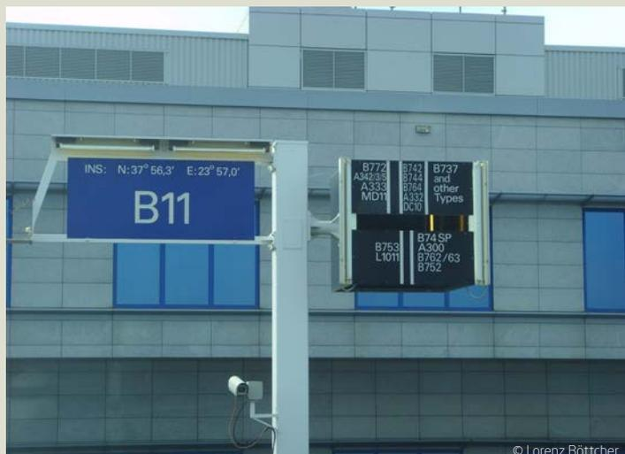
Bild 2: Unübersichtliches und nicht von beiden Pilotensitzen aus erkennbares Andockführungssystem
