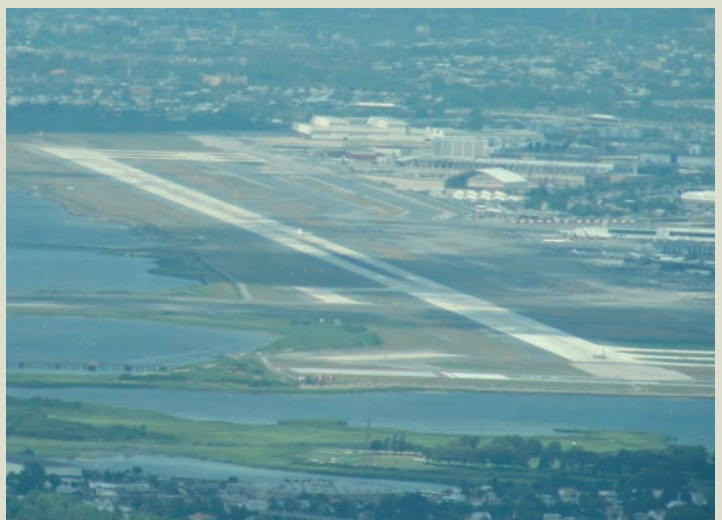
Oben: Unverkürzte Runway End Safety Area (RESA) am Flughafen Miami. Mitte: Nicht ausreichende Runway End Safety Area (RESA). Unten: EMAS Installation JFK RWY 22L.
